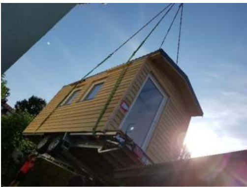
Das Tiny House wird eingeflogen
